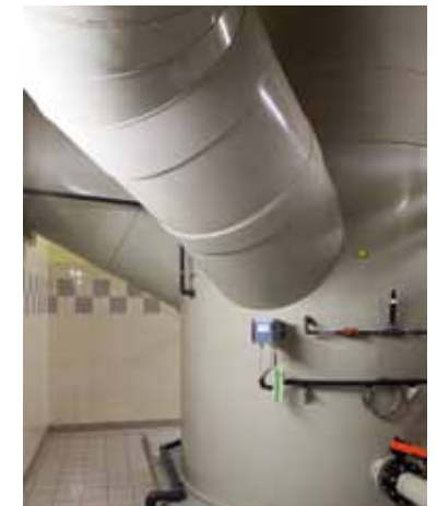
arrivée de l'air à traiter dans la tour
